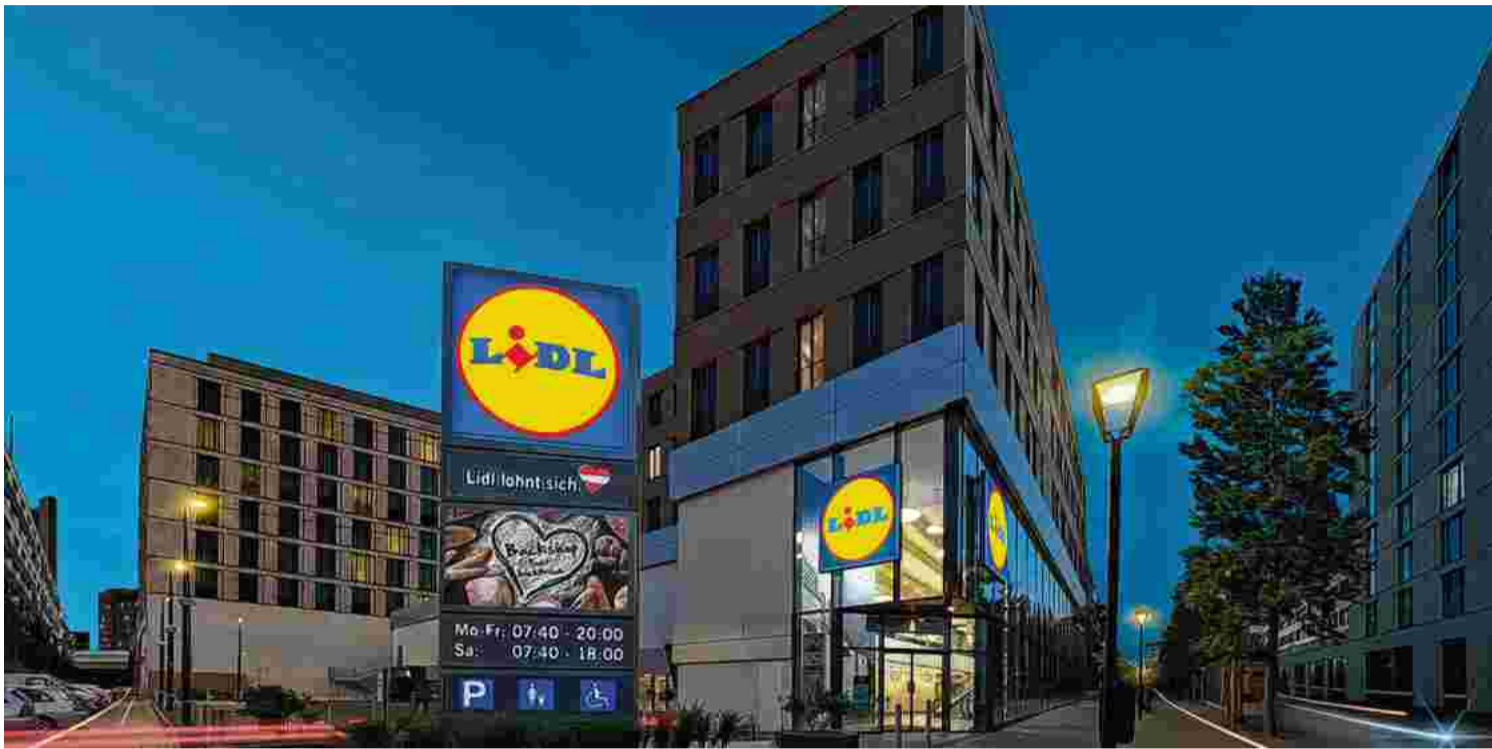
Wohnen über dem Supermarkt: Lidl versucht, mit einem neuen Filialkonzept das knappe Bauland besser zu nutzen.
